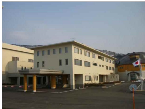
田沢湖スポーツセンター外観
